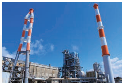
東火力発電所
