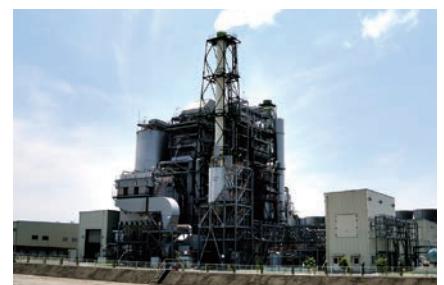
川崎バイオマス発電所
