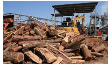
林地残材設備(新居浜西火力発電所) 手前:原木置場 奥右:破砕設備
