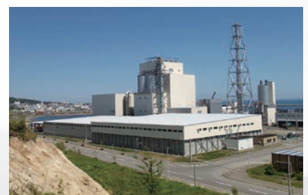
紋別バイオマス発電所
