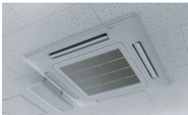
本館・2号館エアコンの更新
